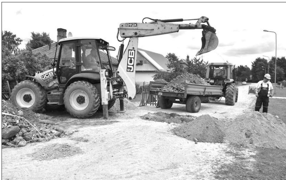
Sešpadsmit mājām Ābeļu ielā, Jēkabpilī būs nodrošināts pieslēgums ūdensvadam, bet vienai – pilsētas kanalizācijas sistēmai.
